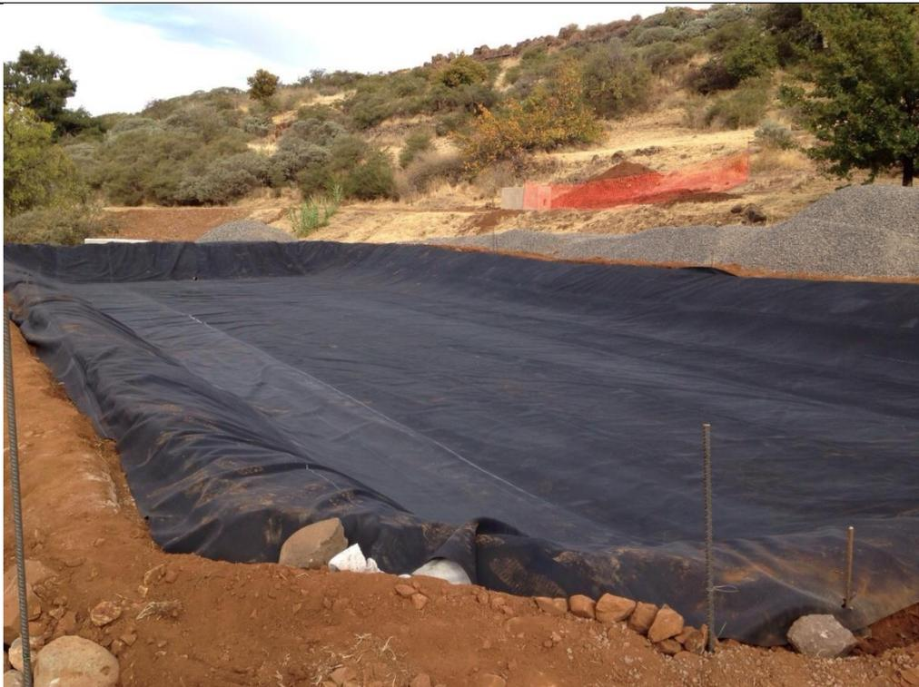
**Fig. 14 - Posa in opera di una geomembrana in EPDM**
