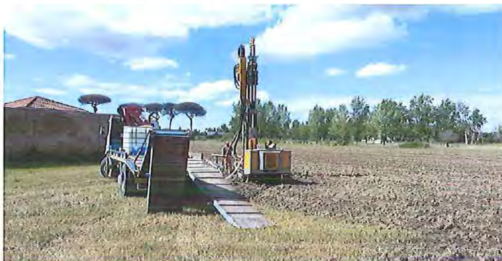
Postazione sondaggio S1
