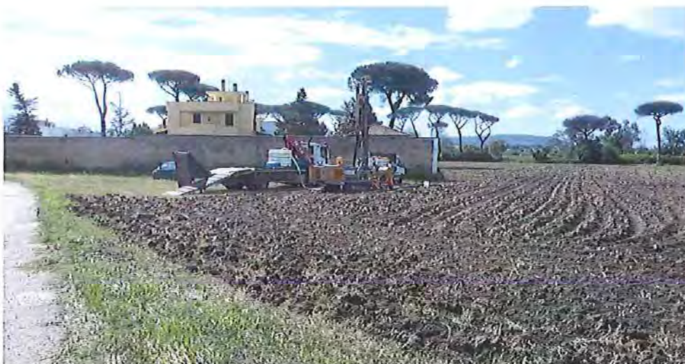
Postazione sondaggio S1
