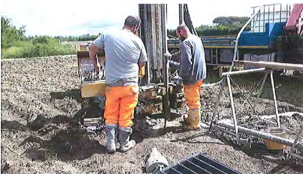
Postazione sondaggio S1
