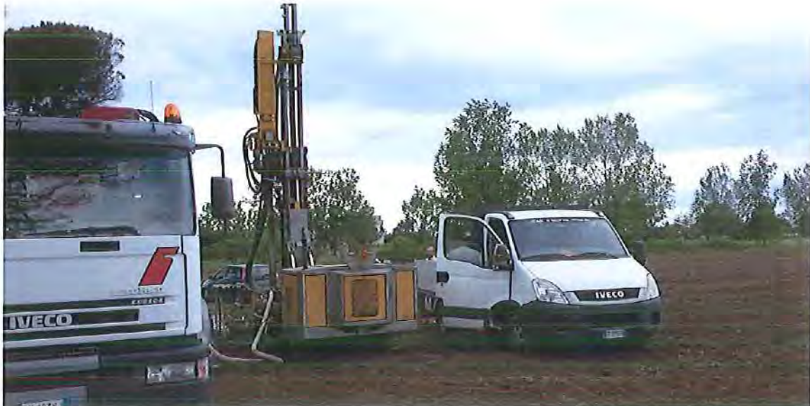
Postazione sondaggio S3
