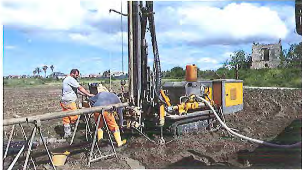
Postazione sondaggio S1
