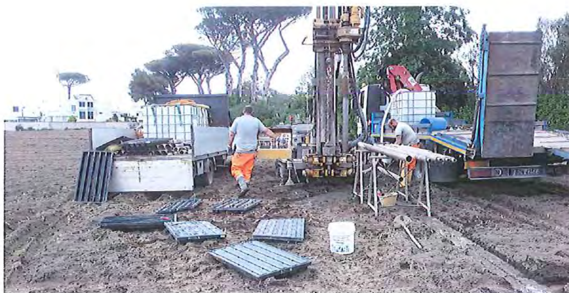
Postazione sondaggio S3
