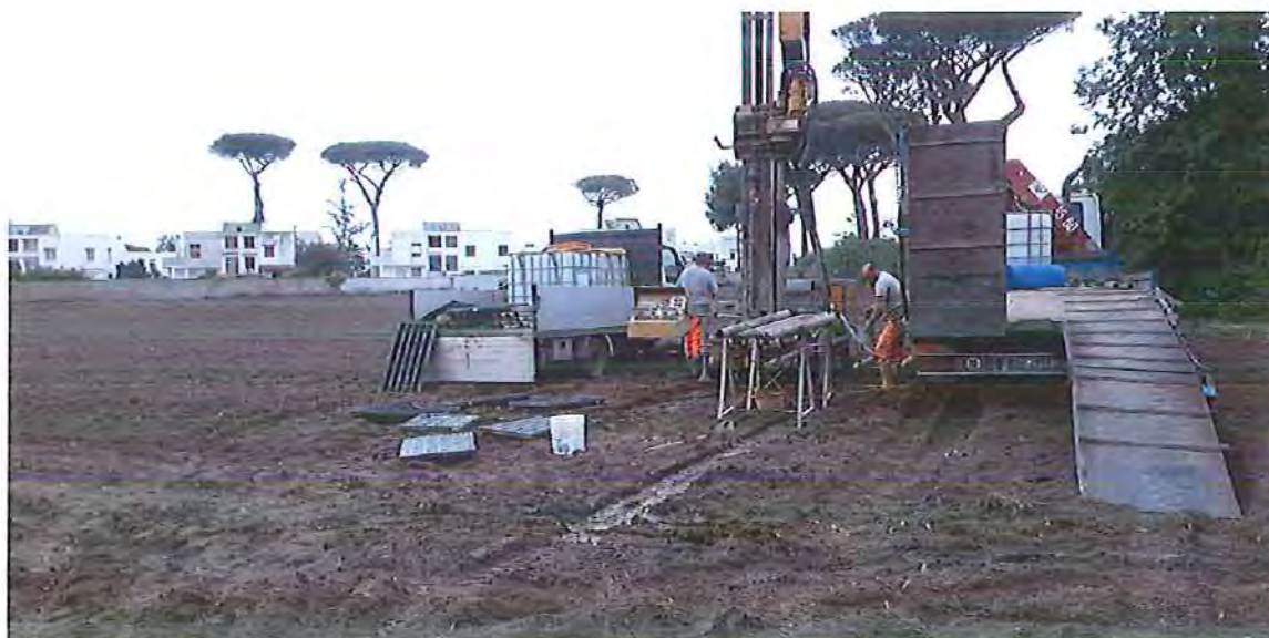
Postazione sondaggio S3
