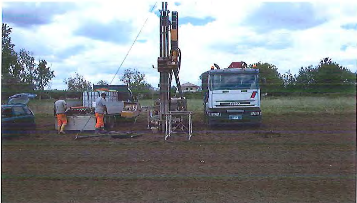
Postazione sondaggio S2
