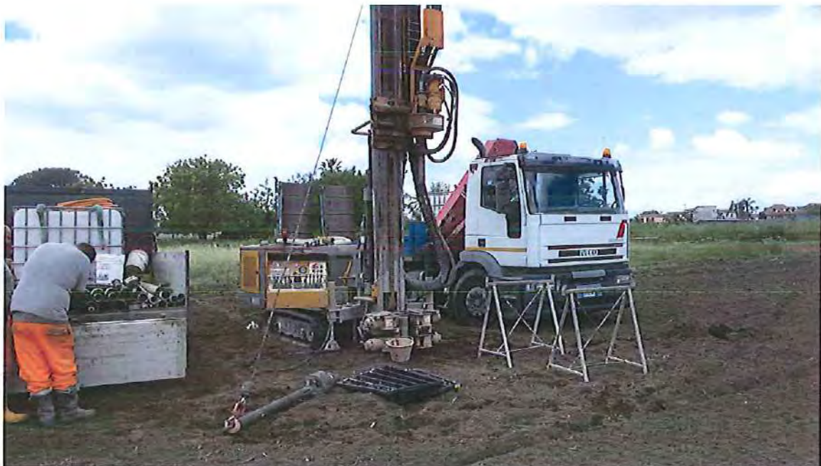
Postazione sondaggio S2
